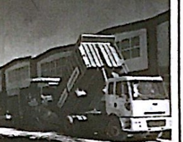
Şahinbey Belediyesi tarafından oto tamirci esnafı için yapılan ve hak sahipleri belirlenen Şahinbey Sanayi Sitesi'nde asfaltlama çalışmaları aralıksız devam ediyor. Başkan Tahmazoğlu, asfalt çalışmalarının ardından Şahinbey Sanayi Sitesinin esnafın taşınması için hazır hale geleceğini söyledi. Belediye ekipleri tarafından şimdiye kadar 8 bin metrekare alanın asfaltlandığı Sanayi Sitesinde 19 bin tona yakın asfaltın döktüğü çalışmaların yaklaşık 20 güne kadar tamamlanması düşünülmüyor. Günde ortalama bin 500 ton asfaltın kullanıldığı çalışmalarda toplamda 40 bin ton asfalt kullanılacak. (Şahinbey Belediyesi)
